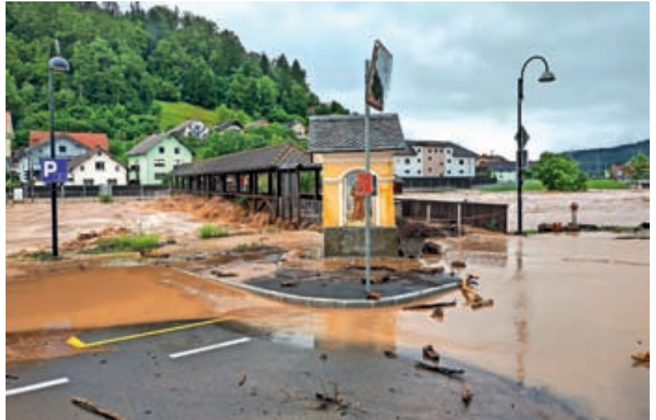
Škoda po avgustovskih poplavah je ocenjena na več kot 32 milijonov evrov (brez škode na stanovanjskih objektih). FOTO: JURE FERLAN
